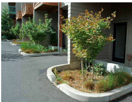
Figur 24. Nedsänkt växtbädd, Portland, USA. Till växtbädden avvattnas takvatten som leds ner i växtbädden genom stuprör. Överskottsvatten bräddas via utsläpp i kantsten och ut på gatan. Foto: Sweco.
