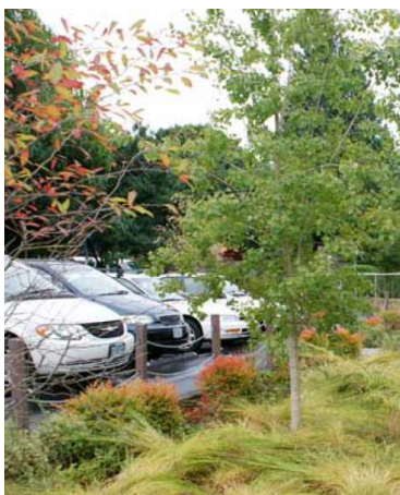
Figur 25. Regngård, Portland, USA. Genom att anlägga regngårdar mellan parkeringsyta och körbanan och luta de hårdgjorda ytorna in mot regngården så omhändertas och renas det ytavrinnande vattnet. Från parkeringen leds vatten in i regngården på bred front då kantstenen är i nivå med asfalten. Vatten från körbanan leds in i regngården via släpp i kantstenen. Foto: Sweco.
