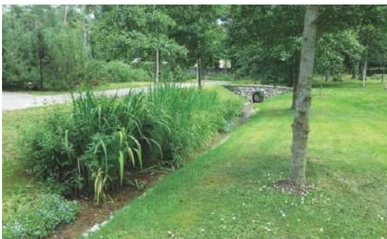
Figur 21. Dike med erosions-skyddande växlighet. Foto: Veg Tech.
