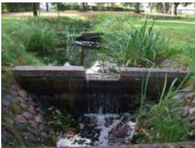
Figur 22. Svackdike med dämnen. Foto: Veg Tech.
