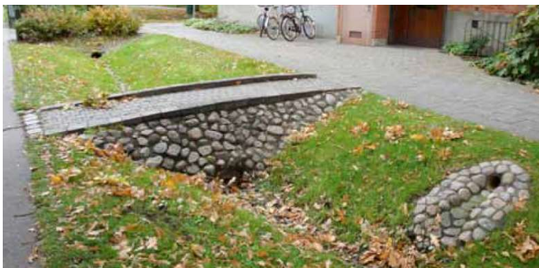
Figur 20. Svackdike med grusfyllning i botten, Augustenborg, Malmö. Ledningen som mynnar i diket är en stuprörsutkastare med erosionsskydd runt. Foto: Sweco.
